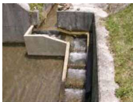
段差解消水路
