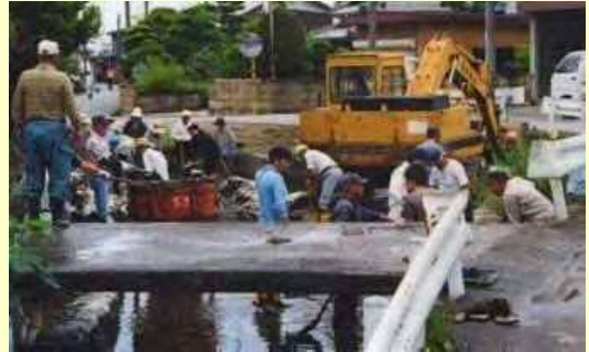
集落での泥上げ作業
