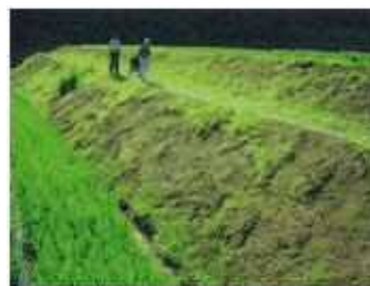
小段が設置されている法面
