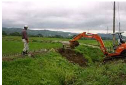
農用地法面の補修
