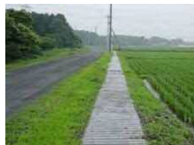
水路へのコンクリート蓋の設置
