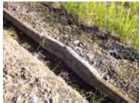
改修したU字溝
