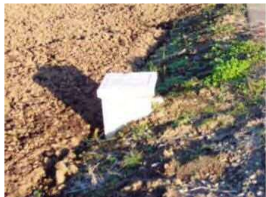
傾いた給水栓ボックス
