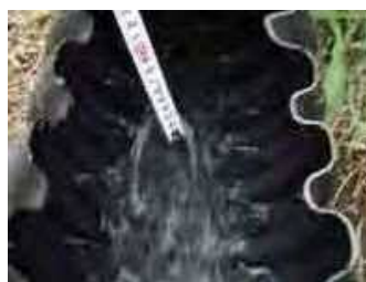
通水試験（水深確認）
