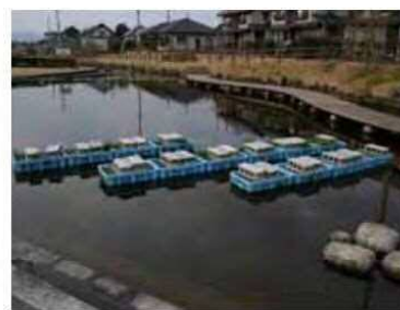
木炭浄化（接触酸化法の一つ）
