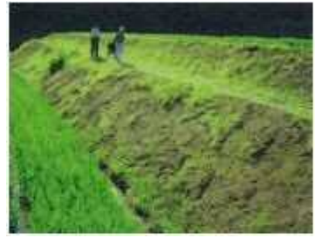
小段（犬走り）設置後の法面
