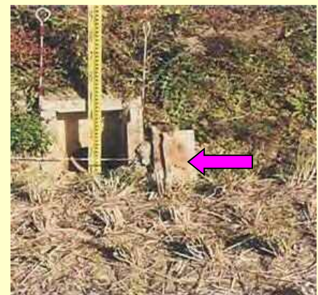
排水調整板設置状況
