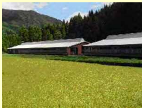
たい肥プラントの外観
