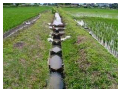
水路魚道（排水路堰上施設）
