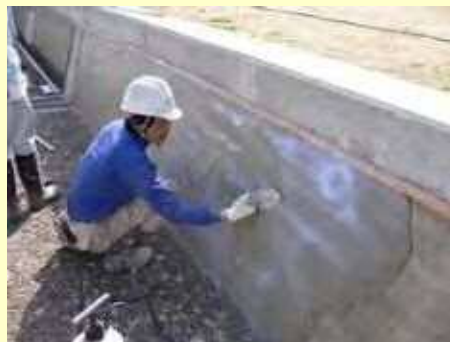
コーティング作業の状況
