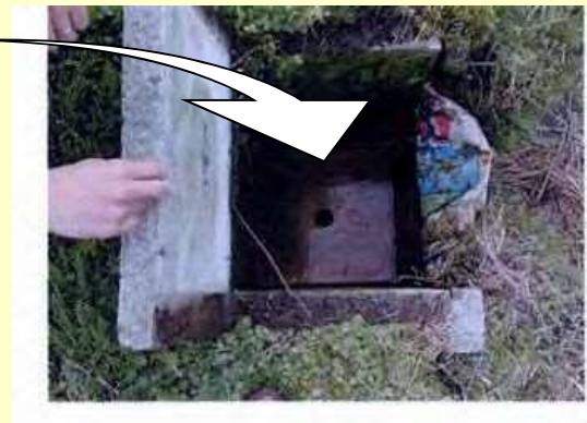
排水調整板設置状況
