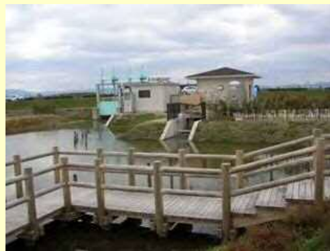
反復利用のための揚水機場と調整池
