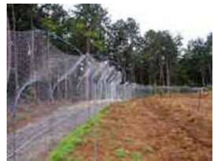
防護柵設置状況
