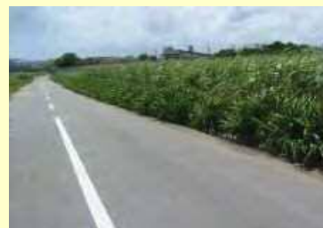
グリーンベルト設置
