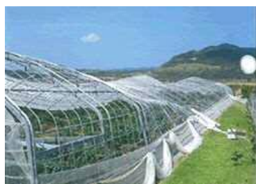
台風により倒壊したビニールハウス
