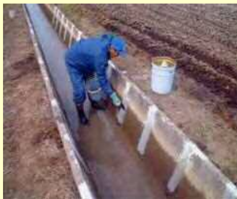
目地詰め作業
