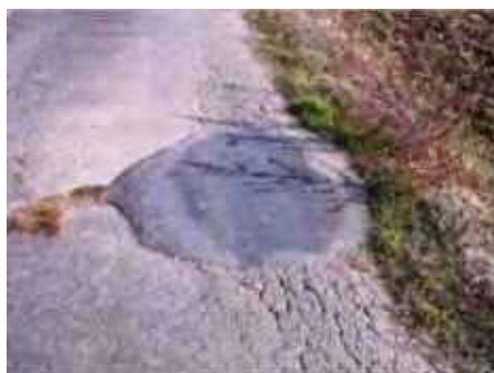
穴・窪みの補修（路面） （アスファルト合材による補修）
