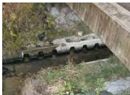
多孔コンクリート護岸
