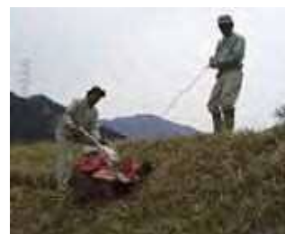
小段設置状況（掘削）
