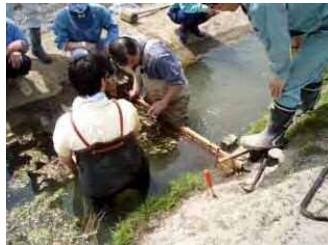
魚道の設置状況（堰板の設置）
