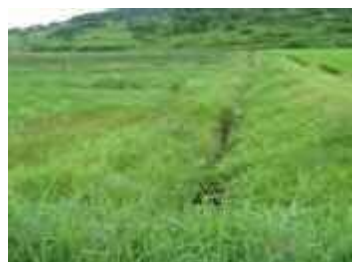
雑草の繁茂状況
