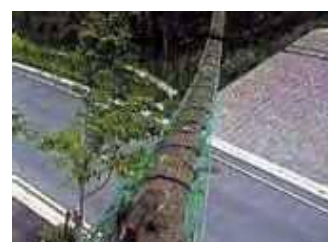
橋梁設置例 （出典：清水建設）
