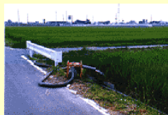
ポンプアップ状況
