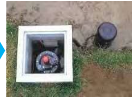
給水栓の自動化へ改良
