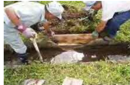
U字溝の改修作業
