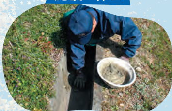
水路の目地補修
