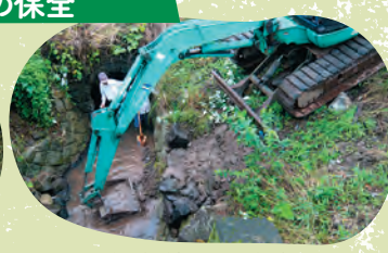
異常気象等後の応急措置
