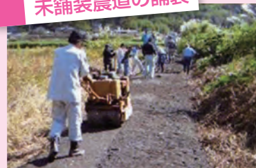
未舗装農道の舗装
