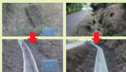
長寿命化による水路の更新
