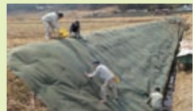
防草シート設置状況
