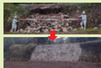
地震による被災箇所の復旧
