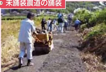
未舗装農道の舗装
