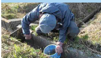
水路の目地補修
