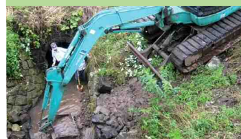
異常気象等後の応急措置
