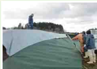
防草シート張り
