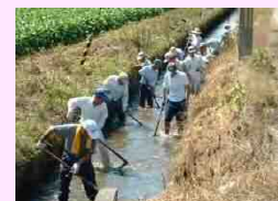
水路の泥上げ
