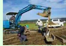
コンクリート水路の更新
