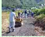
未舗装農道の舗装
