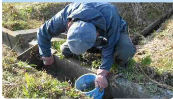
水路の目地補修
