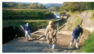
直営による農道舗装
