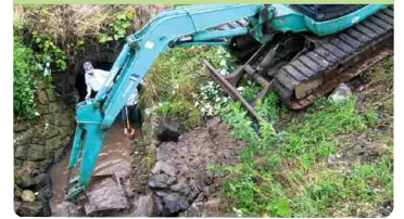
異常気象等後の応急措置
