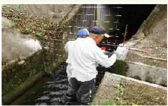
防護柵の設置
